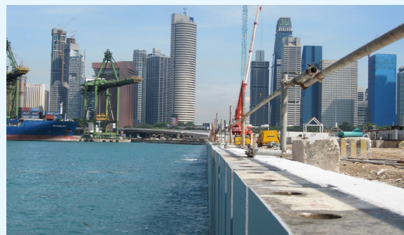
Fertigteil - Hafenmauer Singapur
