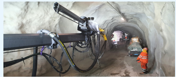
Spritzbeton - Tunnel de Barmasse
